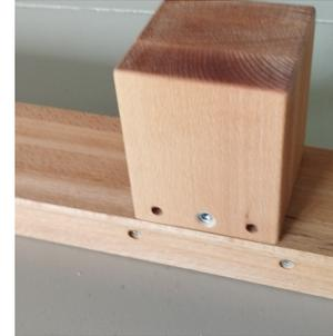
Der Mittelholm wird am Kopfbalken mithilfe einer Schraube fixiert.
